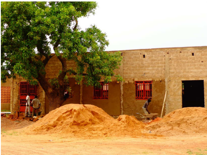
Sala de juegos en construcción
