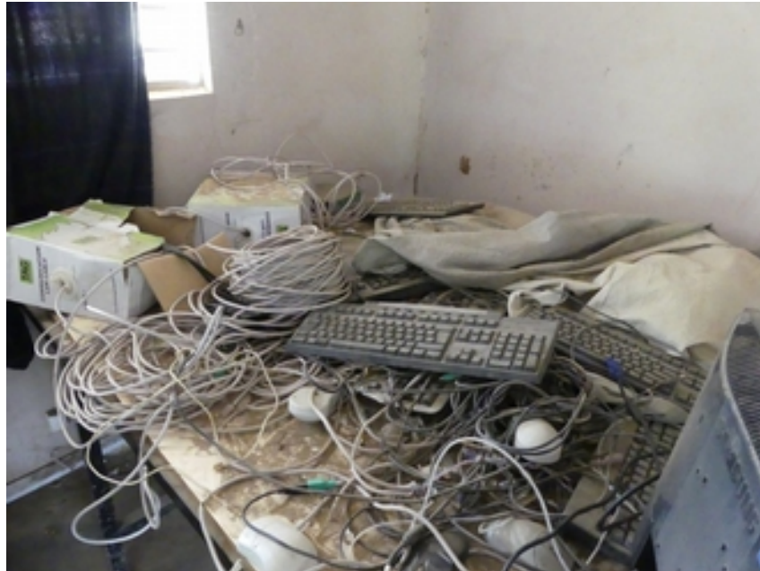
Así estaban los ordenadores cuando llegué. En una sala sin electricidad
