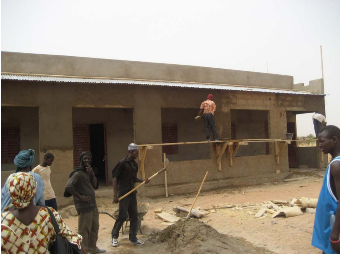
Supervisión de la obra de la nueva escuela de Garmi.
