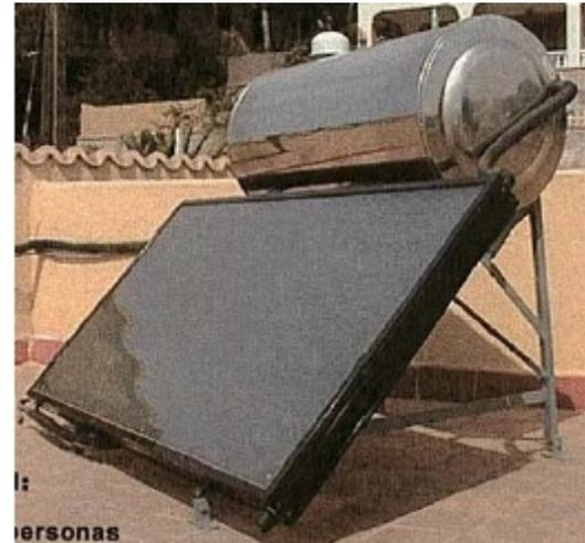
Fotografía y esquema de un sistema de termosifón. Apuntes de energía solar térmica.
